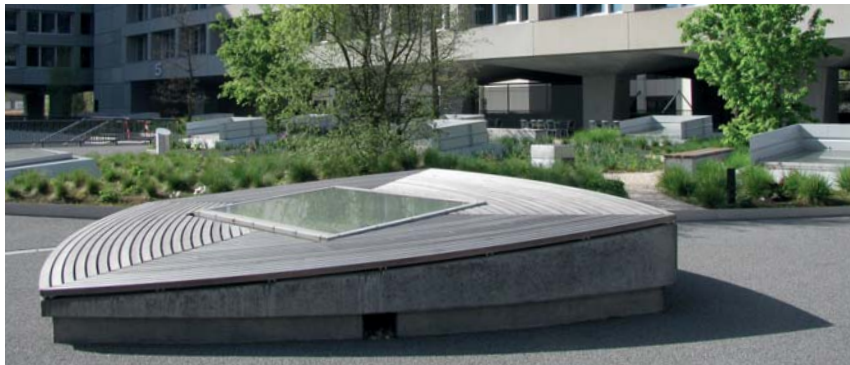
Holzdecks bieten grosszügige Sitzgelegenheiten um die Oberlichter des darunter liegendem Restaurants
