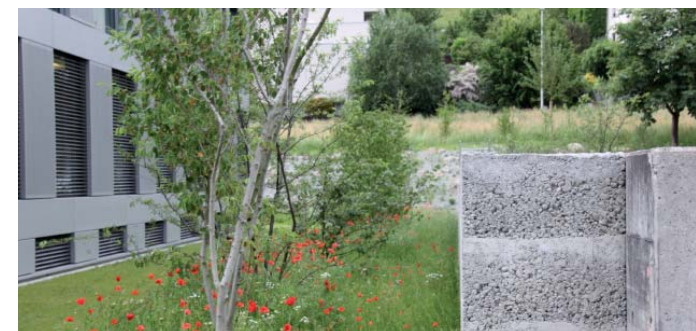
Ergänzte Stampfbetonmauer als grenzbetonendes Element
