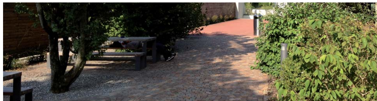
Übergang von der bestehenden Natursteinpflasterung zum roten Asphalt
