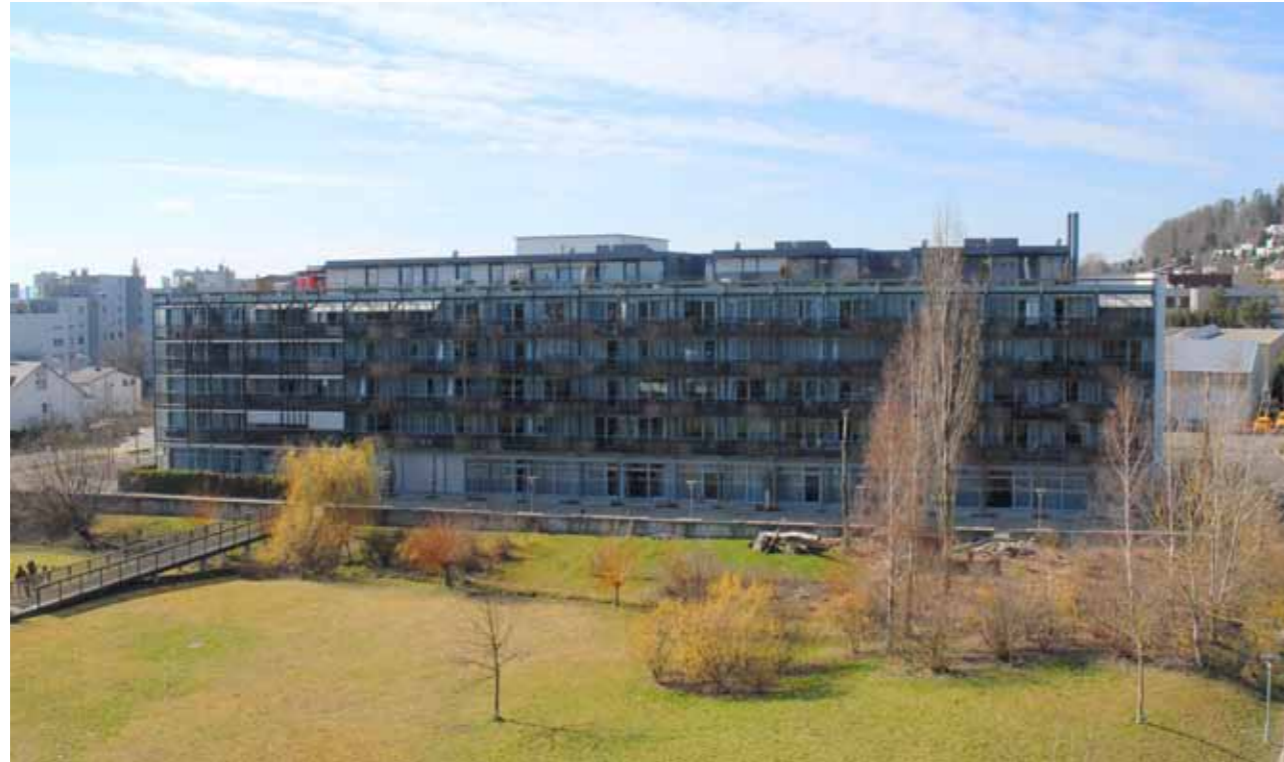
Zwischen Kirche mit Kirchgemeindehaus und dem Altersheim öffnet sich ein Grünraum zur Landschaft
