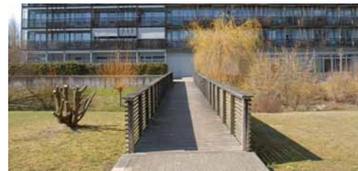
Brücke über den Planzerbach
