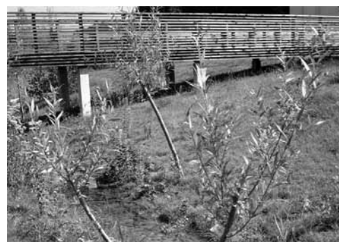
Detail Holzbrücke am Planzerbach mit Weiden
