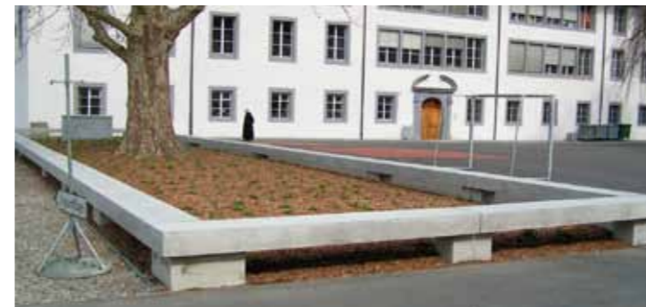
Die Einfassung des Baumstandortes dient als Sitzelement und räumliche Trennung der beiden Teilräume Klosterhof und Konventgarten
