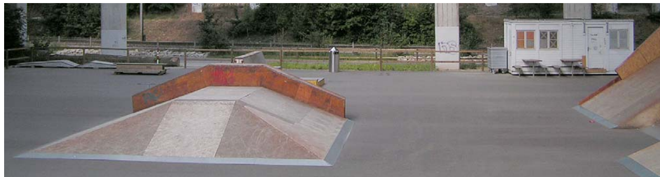
Im Regenschatten der Autobahnbrücken kann auch bei schlechtem Wetter an den neuesten Skate-Tricks geübt werden
