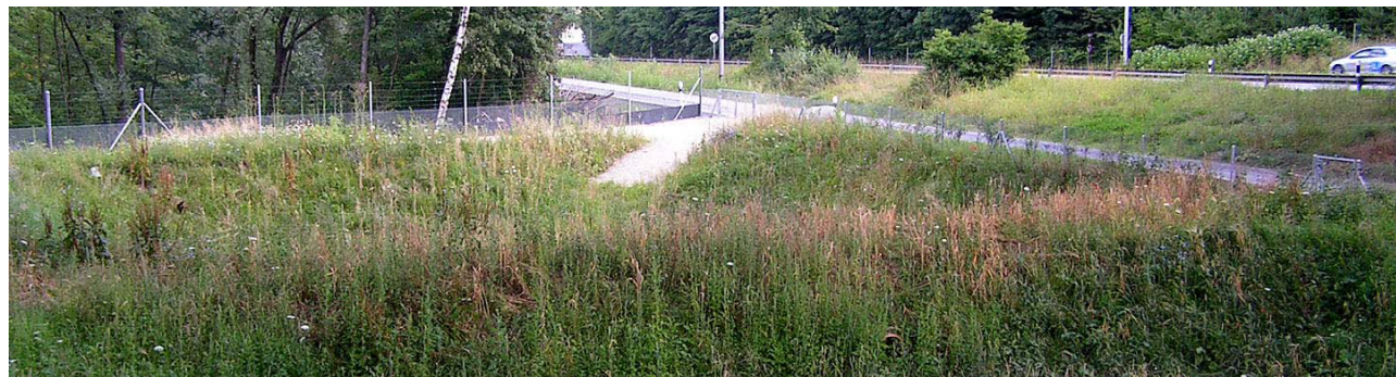
Die Retentionsfilterbecken sind aus ästhetischer und ökologischer Sicht eine Bereicherung im Dättwiler-Tal
