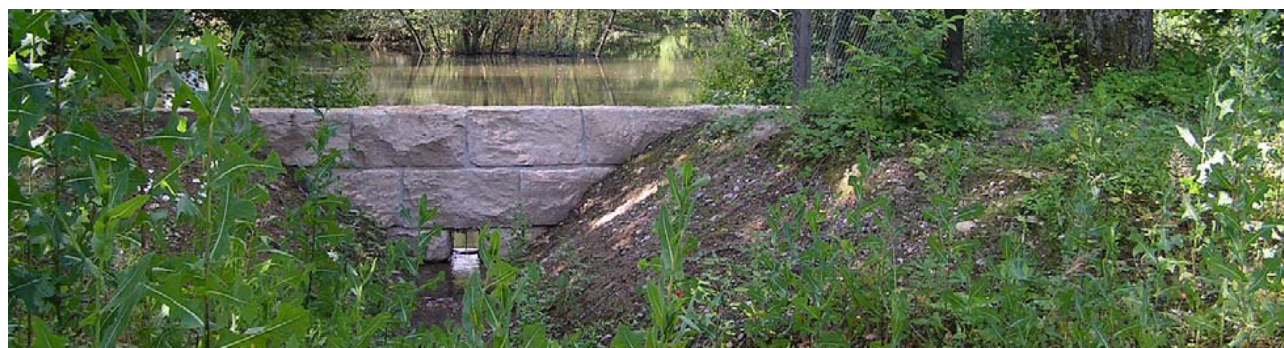
Der neugestaltete Auslauf des Dättwiler-Weiher
