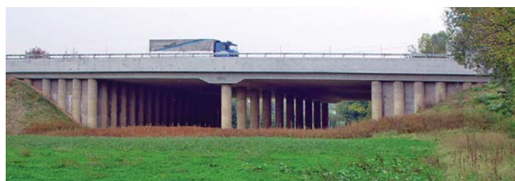
Wildtierunterführung der N1 (Grosszelg), 30 m breite Unterführung
