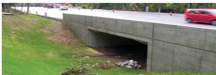
Kleintierdurchlass Weierhau, ca. 8.5 m breite Unterführung mit Leitensystem
