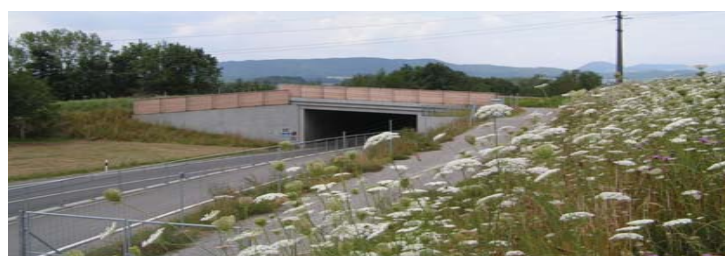
Wildtierüberführung der K419 (Grosszelg), 40 m breite bewachsene Brücke
