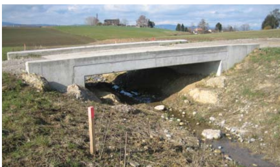
Flurwegbrücke über neu erstelltem Ghürschbach
