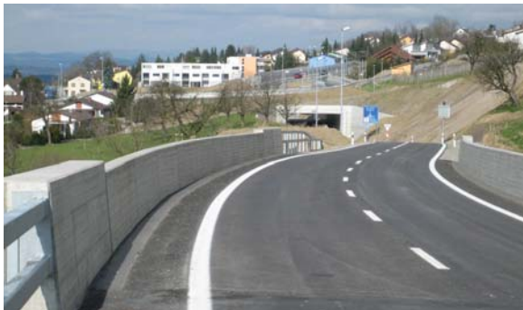
Strassenbrücke mit Tunnelportal
