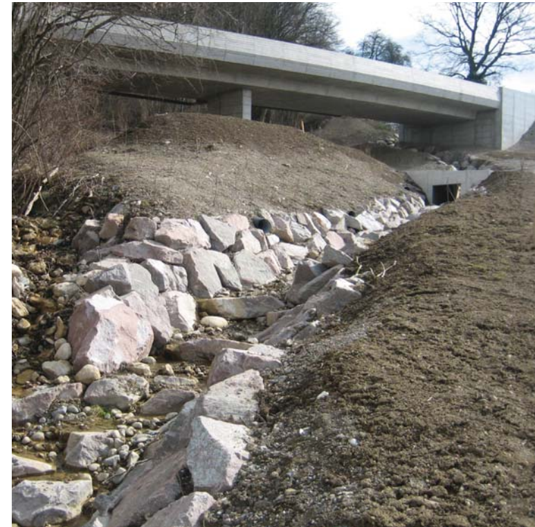
Strassenbrücke über kleinem Bachtobel mit Bachdurchlass
