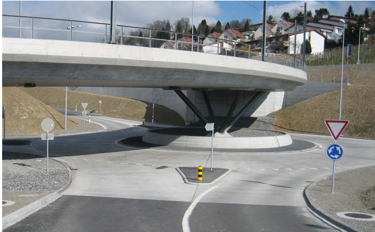
Kombinierte Eisenbahn-, 1 Spur-Strassenbrücke mit Ausbildung Kreiselmitte
