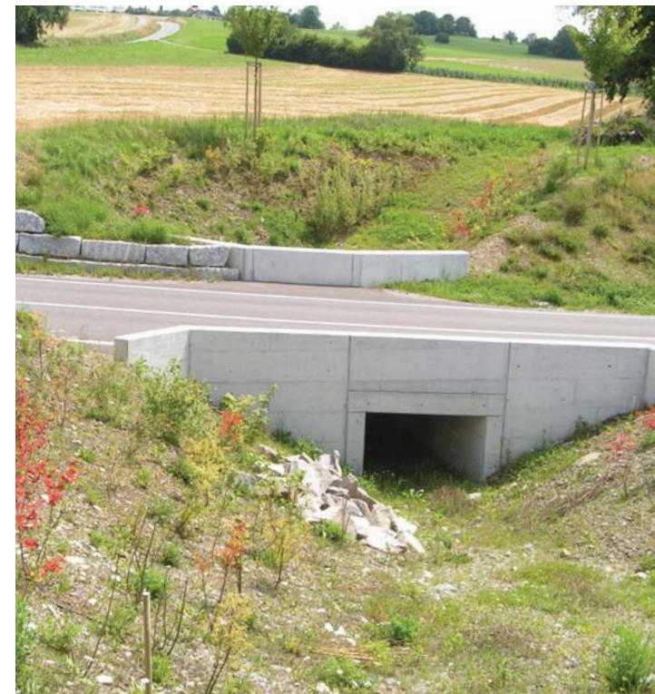
Kleintierdurchlass an der Sädelstrasse
