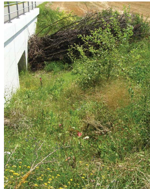
Zulenstrukturen am Kleintierdurchlass
